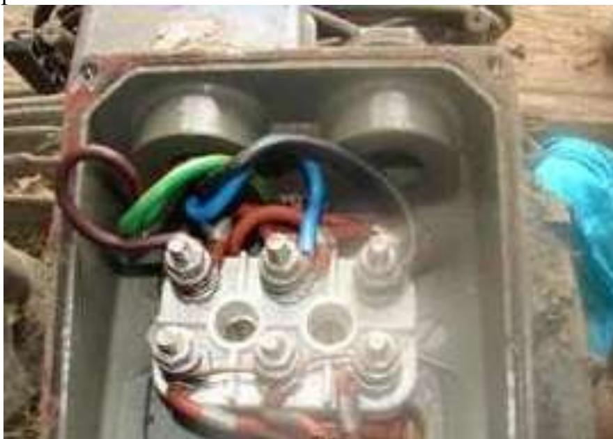
Рисунок 3 – Соединение обмоток двигателя по схеме «треугольник»
